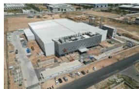
インド新生産拠点（建設中）
