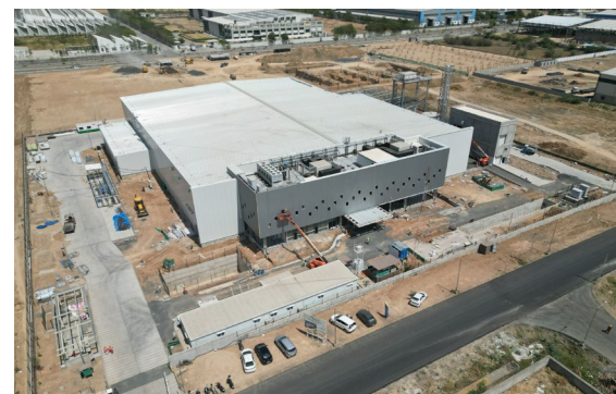
インド新生産拠点 (建設中)
