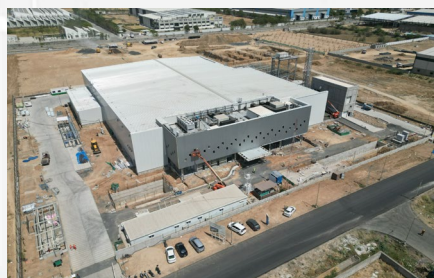
インド新生産拠点（建設中）
