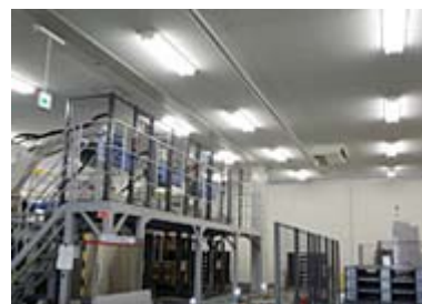
LED照明(小野工場)
