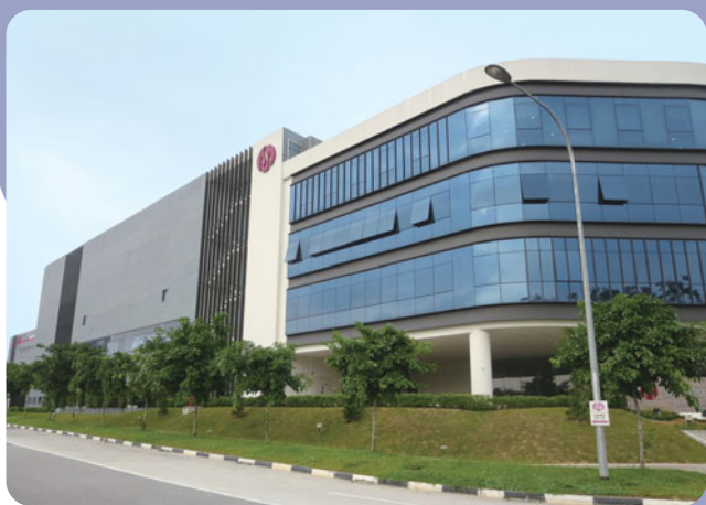
新試薬工場が入居するビル
