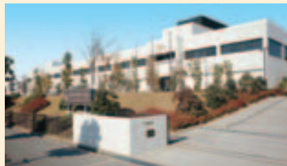
国際試薬(株)西神工場
