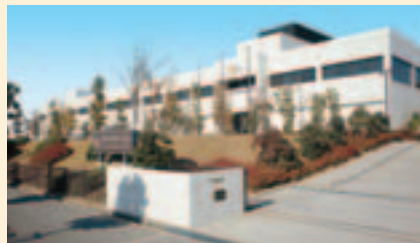
国際試薬(株)西神工場
